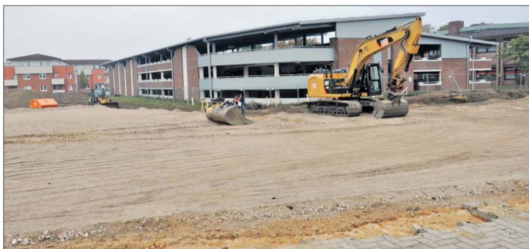
Auf dieser Fläche soll der neue Block mit dem Dodenhof-Modegeschäft entstehen. Zudem ist geplant, die Parkpalette (hinter dem Dodenhof-Block) dreigeschossig zu erweitern. Foto zwi
