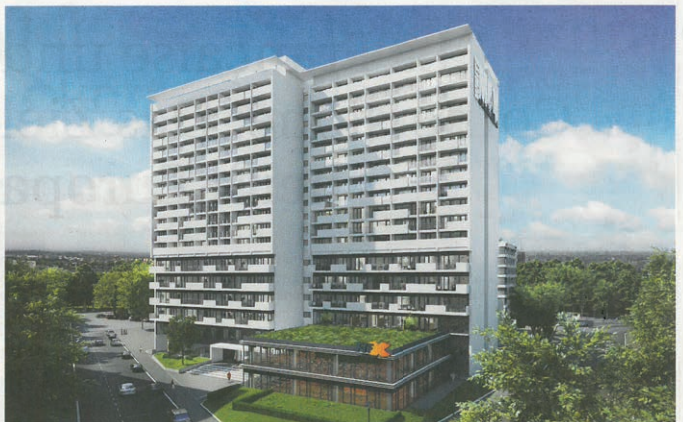
Das White Max am Düsseldorfer Seestern ist eines der Meisterstücke von Ferox. Hier entstanden aus einem in die Jahre gekommenen Büro- und Wohnkomplex 305 moderne Wohnungen. Stef. Ferox
